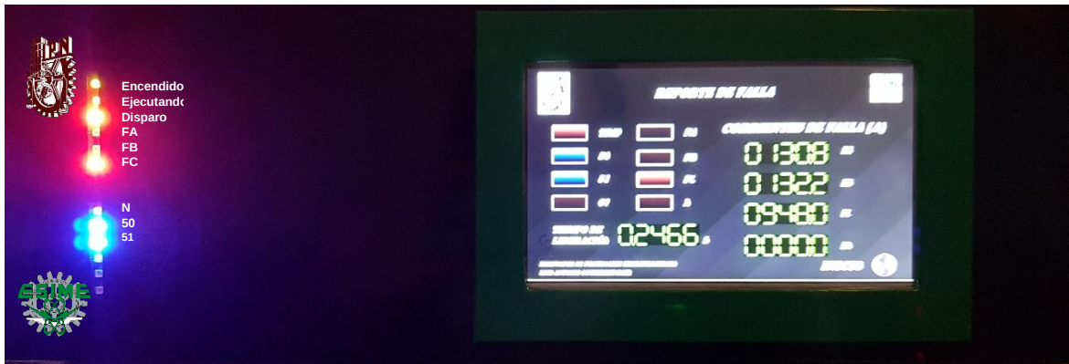
Figura 5. 14. Panel frontal en condiciones de falla de 16 A RMS en la fase “C”.
